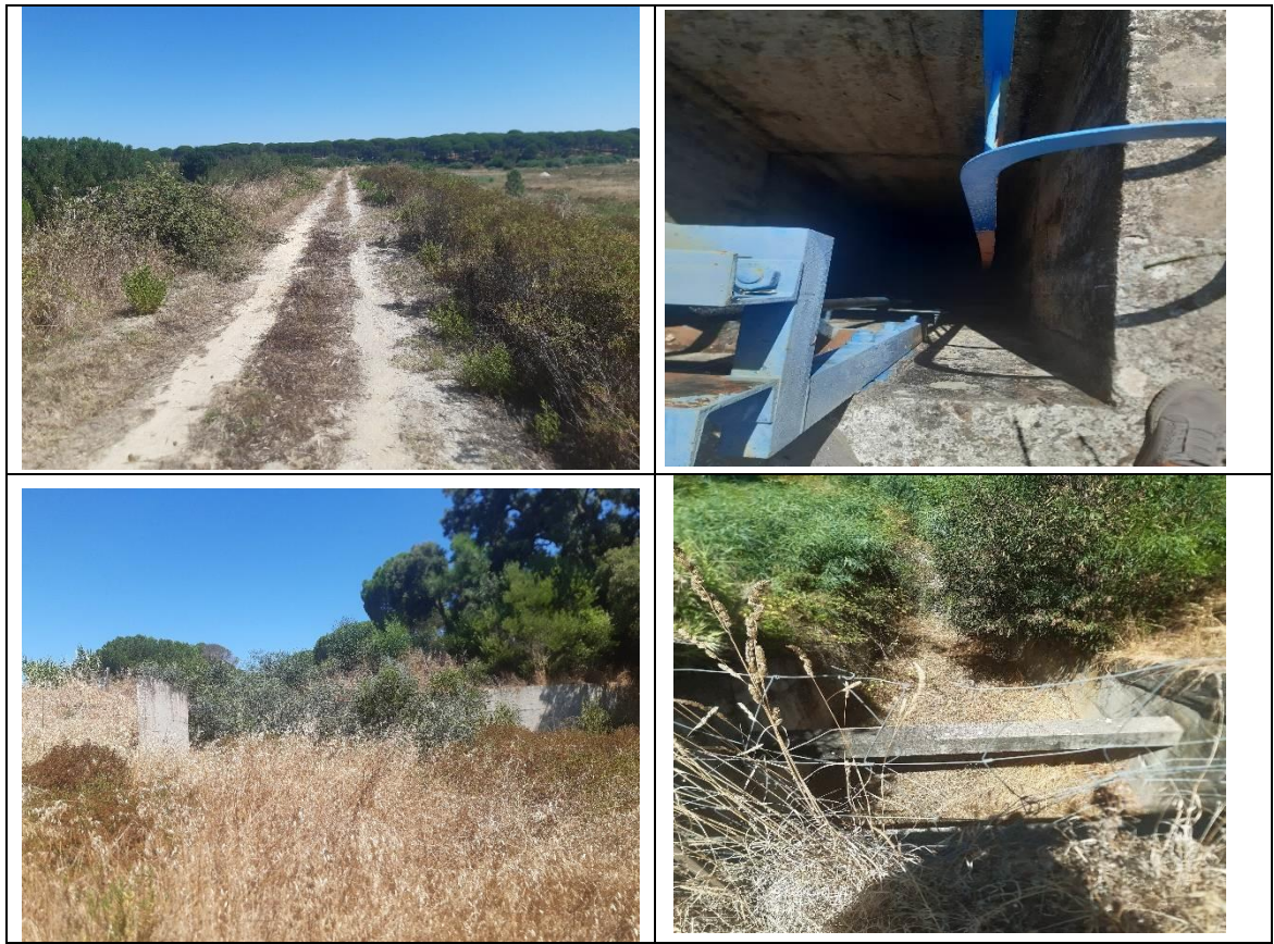
Figura 29 – Aspecto do corpo da barragem, em cima á esquerda. Aspecto do descarregador de fundo, em cima à direita. Em baixo, aspecto do descarregador de superfície
