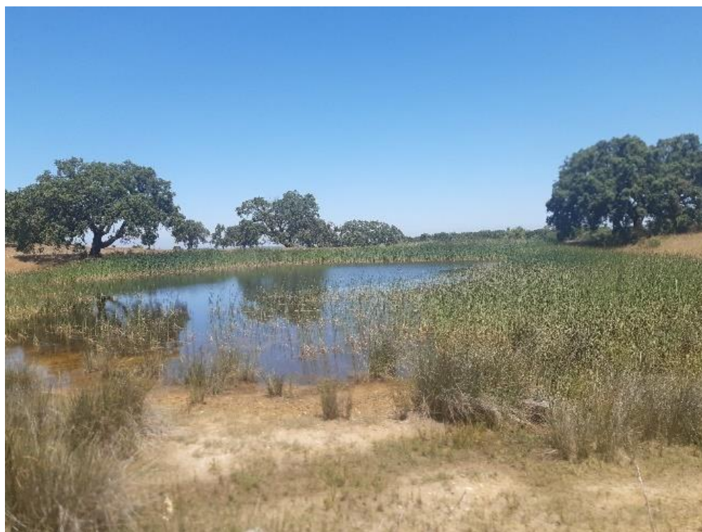
Foto 8 – Aspecto da Barragem E.
