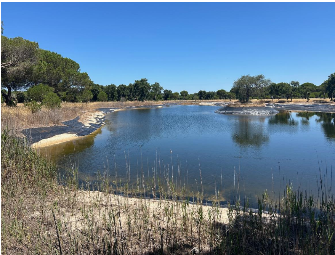
Foto 5 - Aspecto da barragem A e sua impermeabilização com geomembrana.
